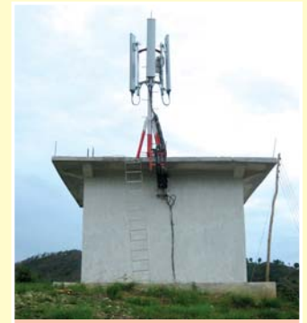
समुदायको पहलमा निर्मित विटिएस साइट भवन
